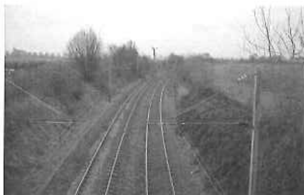
Figure 38 : voie ferrée Paris - Luzarches à hauteur de Maffliers, source EGIS Structure et Environnement, 2010
