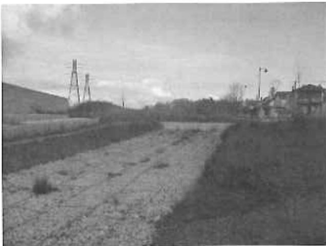
Photo 12 : principe de gabion matelas à proximité du ru de Presles à Mours, cliché EGIS
